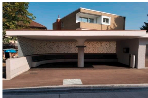
Sirnach, Buswarteraum Bahnhof
