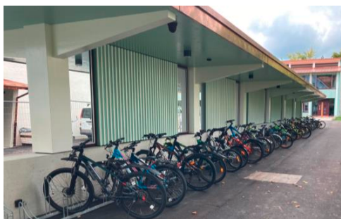
Münchwilen, VAA Schulanlage Oberhofen
